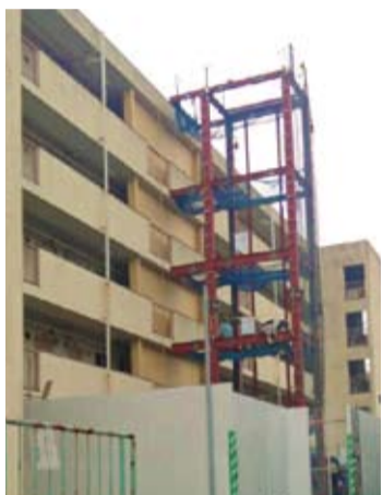
市営住宅のエレベーター設置工事
